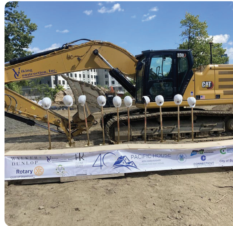
Rotary Commons Groundbreaking
